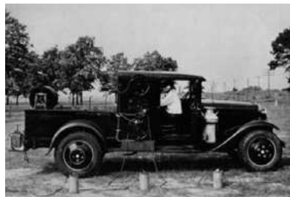
Ciężarówka Geophysical Service z wyposażeniem do odczytów sejsmicznych, a obok niej geofony - czujniki drgań.
